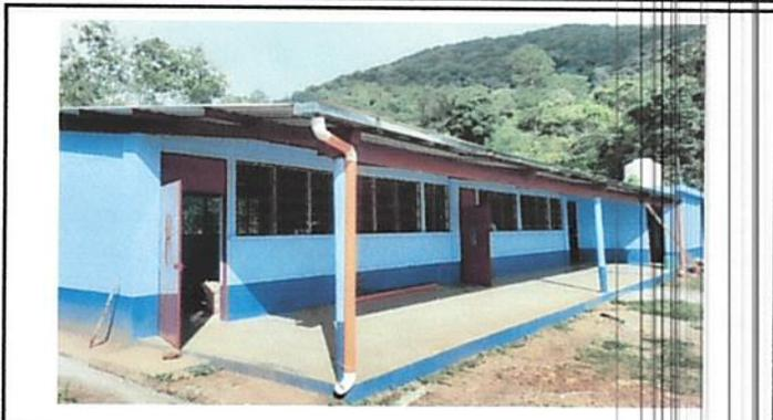
Foto 2: Instalación de canales y bajadas de agua.
